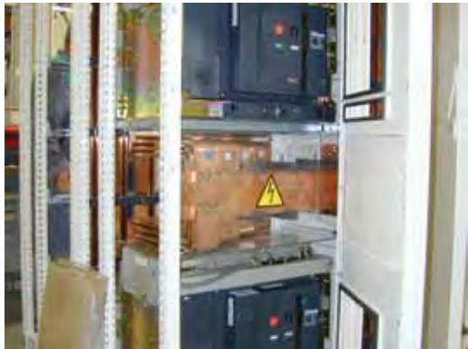
Система ввода резерва, размещенная в одной ячейке
